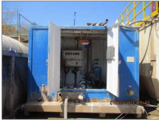
รูปที่ 2-10 จุดเติมน้ำมันเชื้อเพลิง
