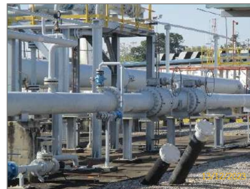
รูปที่ 2-43 ฝาคอบ หรือ ที่อุดปิดปลายท่อซึ่งไม่ต่อกับอุปกรณ์อื่น
