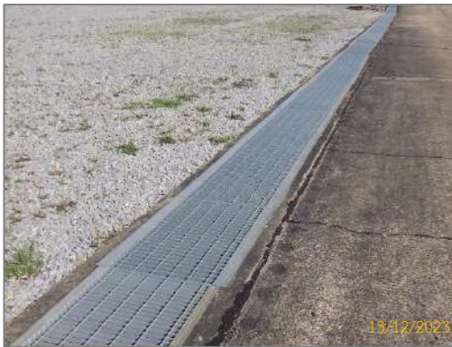
รูปที่ 2-30 (ต่อ) รางระบายน้ำรอบพื้นที่โครงการฯ
