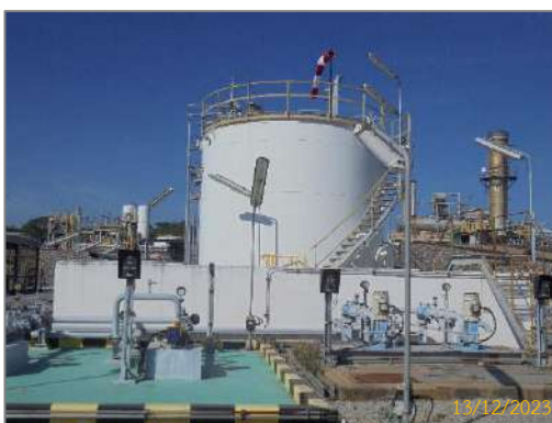
รูปที่ 2-36 คั่นคอนกรีตล้อมรอบถังคอนเดนเสท
