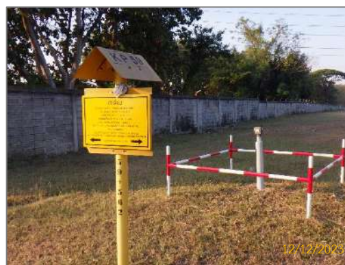
รูปที่ 2-54 จุดตรวจสอบการผูกมัดของผิวท่อ (Cathodic Protection Test Points)
