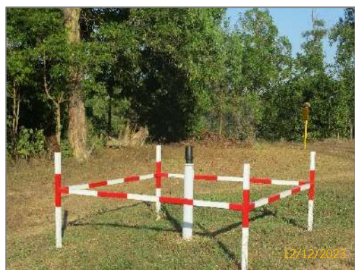
รูปที่ 2-54 จุดตรวจสอบการผูกมัดของผิวท่อ (Cathodic Protection Test Points)
