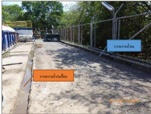
รูปที่ 2-4 ระบบระบายน้ำแบบแยกส่วน
