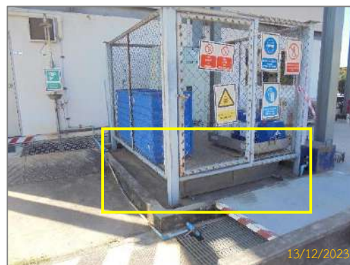
รูปที่ 2-37 บ่อรับน้ำปนเปื้อนบริเวณพื้นที่จัดเก็บสารเคมี
