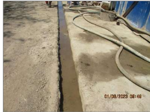
รูปที่ 2-5 รางดักน้ำปนเปื้อนรอบพื้นที่หลุมเจาะ
