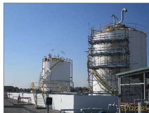
รูปที่ 2-36 คั่นคอนกรีตล้อมรอบถังคอนเดนเสท
