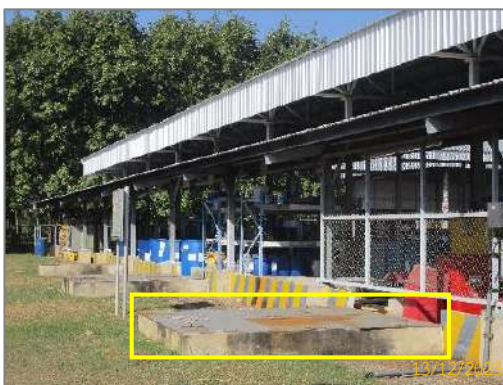
รูปที่ 2-37 บ่อรับน้ำปนเปื้อนบริเวณพื้นที่จัดเก็บสารเคมี
